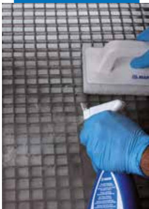
Vaporisation de Kerapoxy Cleaner sur la surface à nettoyer
