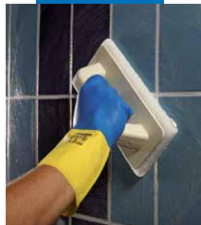
Kerapoxy CQ est émulsionné à l'eau en utilisant un frottoir Scotch-Brite®
