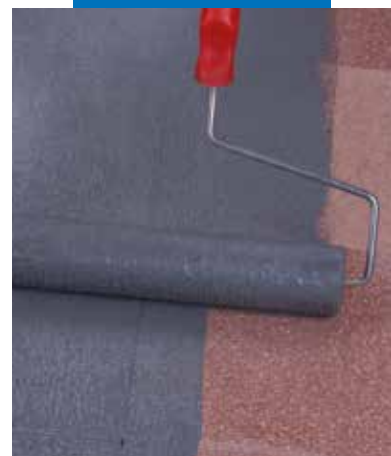
Application d'Eco Prim Grip au rouleau sur sol terrazzo existant
