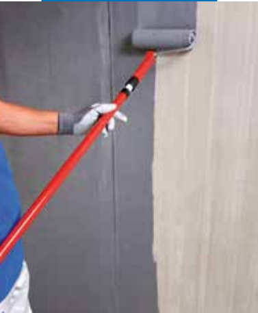
Application d'Eco Prim Grip au rouleau sur support béton
