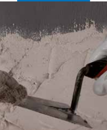
Application d'un enduit sur Eco Prim Grip
