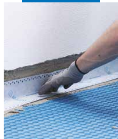
Imperméabilisation des contours avec Mapeband Easy, collée avec Mapeguard WP Adhesive
