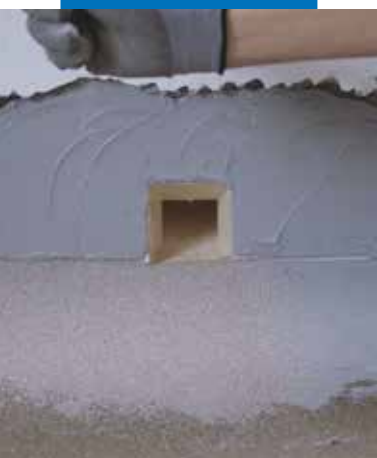
Imperméabilisation de l'écoulement avec Drain Front
