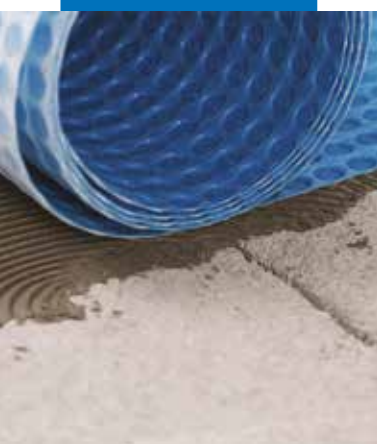
Pose de Mapeguard UM 35
