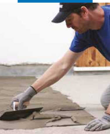
Application du mortier- cole avec la spatule dentée n° 5
