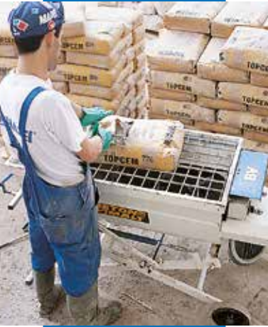
Mixage de Topcem à l'aide d'un mélangeur horizontal
