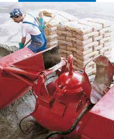
Mélange de Topcem à la pompe à pression automatique
