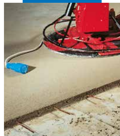
Finition de la chape avec un hélicoptère à béton
