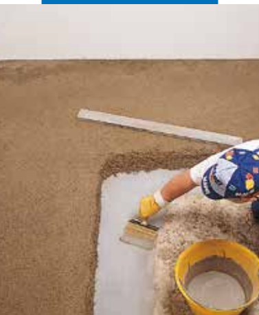
Application de la barbotine d'accrochage pour chape adhérente Topcem
