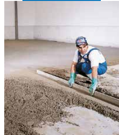
Préparation de bandes de nivellement
