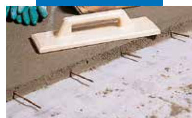
Détail d'une chape de Topcem avec fers de reprise
