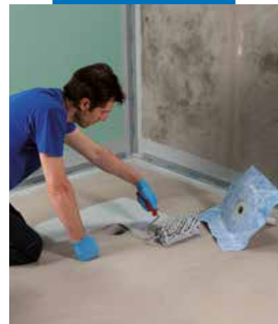
Application d'un drain vertical avec Mapegum WPS
