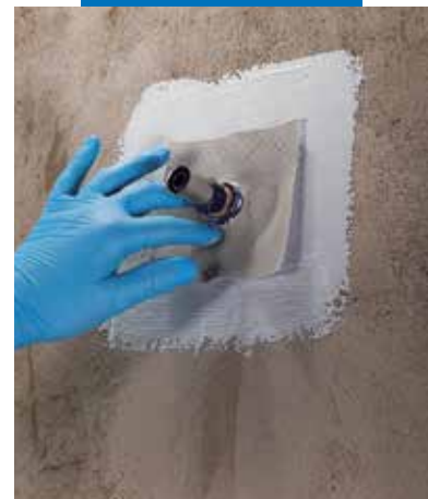
Application de joint Mapeband PE 120 dans des trous en utilisant Mapegum WPS
