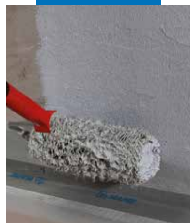
Application de Mapegum WPS au rouleau
