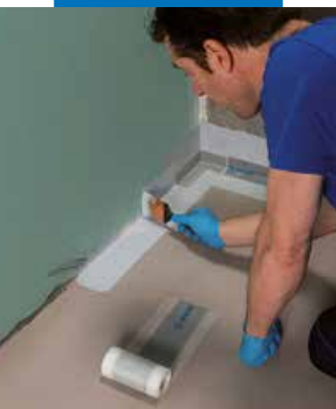
Application de Mapeband PE 120 avec Mapegum WPS
