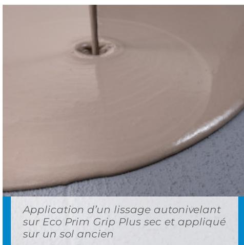
Application d'un lissage autonivelant sur Eco Prim Grip Plus sec et appliqué sur un sol ancien
