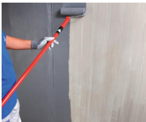
Application d'Eco Prim Grip Plus au rouleau sur du béton
